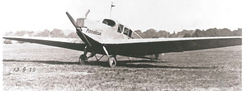
Junkers F13, 1919, erstes Ganzmetallflugzeug der Welt, gefertigt aus Duraluminium
